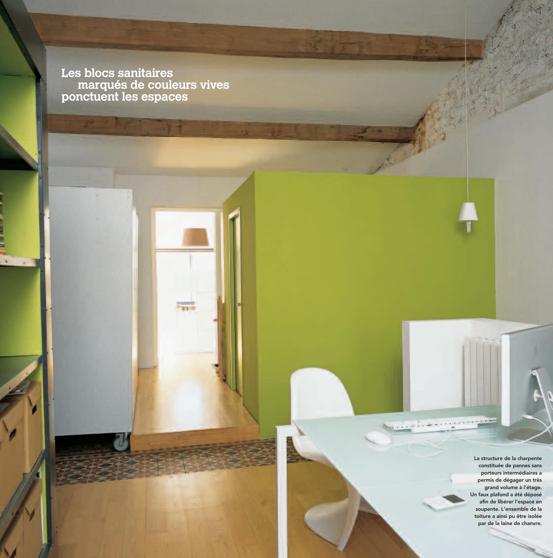
La structure de la charpente constituée de pannes sans porteurs intermédiaires a permis de dégager un très grand volume à l'étage. Un faux plafond a été déposé afin de libérer l'espace en soufflete. L'ensemble de la toiture a ainsi pu être isolée par de la laine de chanvre.
